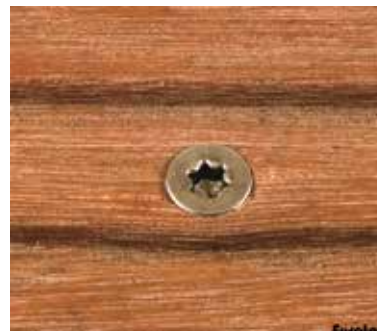
Vorbohren + Terrassotec-Schraube
