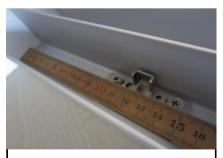
Fanghaken 124mm mittig anschrauben. Zur Führungsschiene ca. 2mm Luft lassen. Einhängen der Türe mit gespannter Feder.
