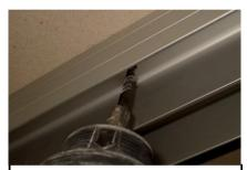
Befestigen Sie die Führungsschiene an der Decke.
