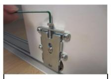
Die Höhe kann man mit einem Inbus Nr. 2 verstellen. Wenn die gewünschte Höhe eingestellt ist mit der Schraubmutter fixieren.
